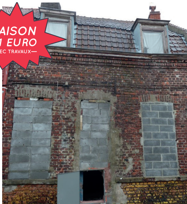
Façade actuelle côté rue
