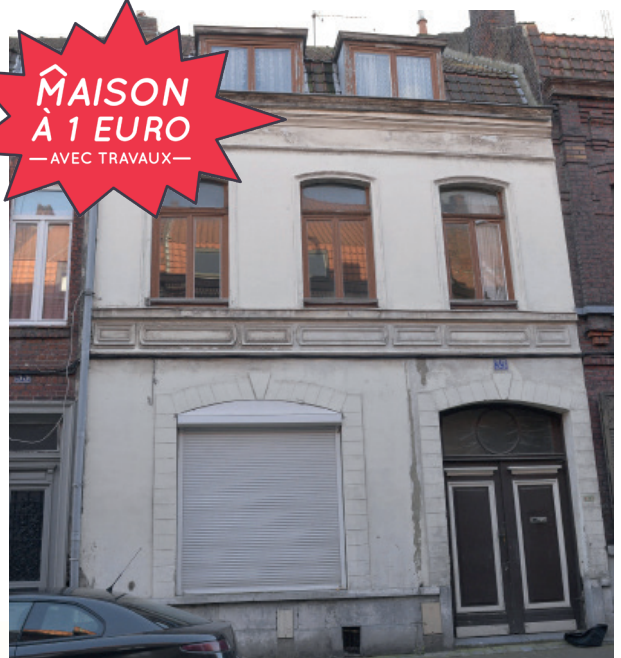
Façade actuelle côté rue
