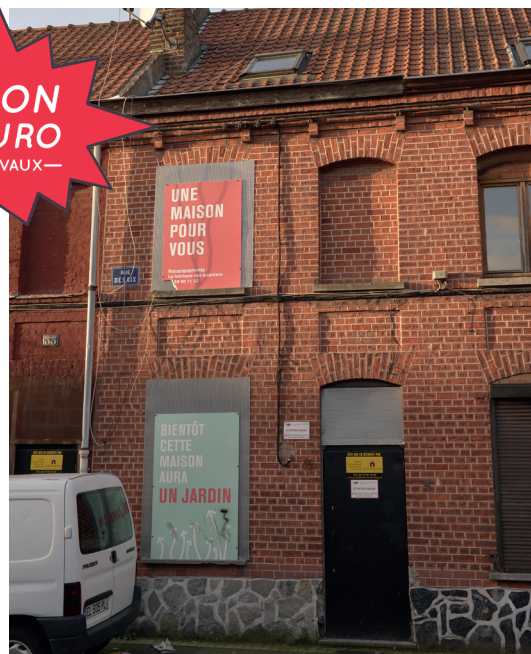
Façade actuelle côté rue
