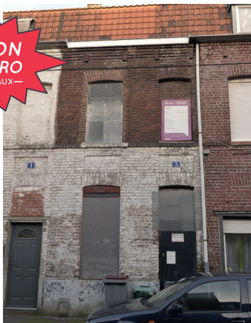
Façade actuelle côté rue
